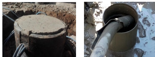
图5 试验桩制作过程
